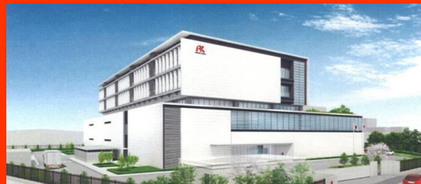
新開発センター（春日部市） 2015年1月稼働
